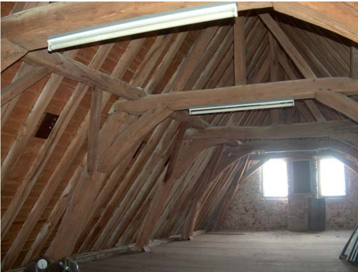
1 ZOLDER VOOR RESTAURATIE, DE KAPCONSTRUCTIE WORDT VOLLEDIG ERVAREN EN DAGLICHT KAN TOT DE RUIMTE TOETREDEN.
