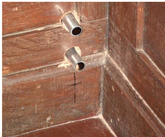
3 DOORVOER VAN VERWARMINGSLEIDINGEN DOOR EEN HOUTEN AUTHENTIEKE LAMBRISERING (BOVEN) EN NIEUWE(RE) PLINT (ONDER).
