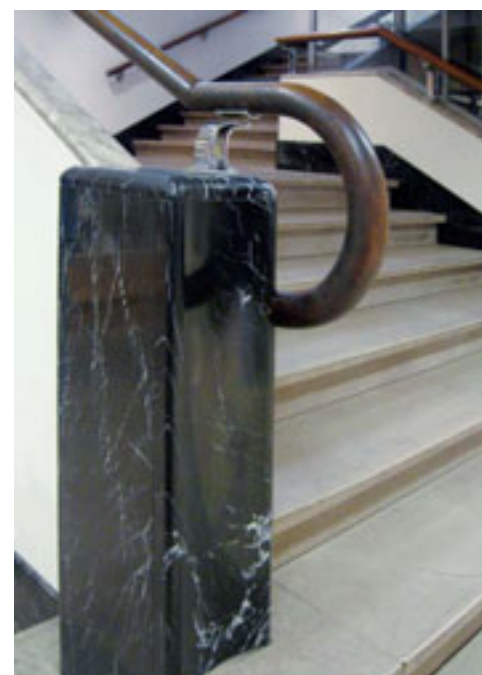
8 - INTERIEUR VAN DE V&D IN AMERSFOORT. TRAPTREDEN VAN LUNEL, AFDEKKING TRAPPAND VAN NAPOLEON, HARPSTUKKEN EN TRAPPAAL VAN BLEU BELGE.
