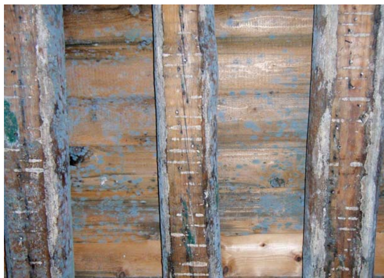
4 – VOOR HOUT ONSCHULDIGE OPPERVLAKTESCHIMMELS OP VLOERDELEN EN BALKEN, ENIGE WEKEN NA DE BRAND (FOTO DIMITRA HIERCK)
