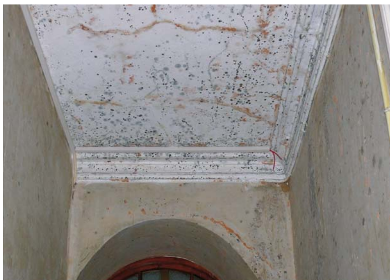
3 – EEN EXPLOSIE VAN SCHIMMELS OP STUCWERK ENIGE WEKEN NA DE BRAND (FOTO BIRGIT DUKERS)
