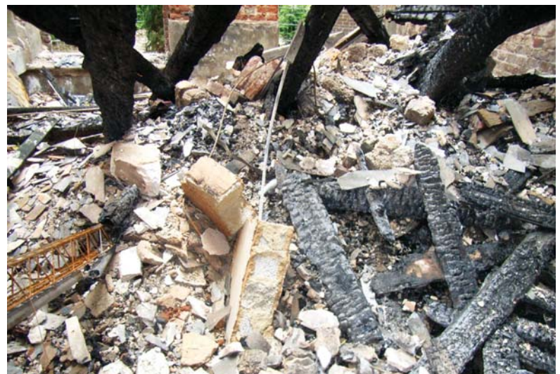
9 – OPEENGEHOOPT PUIN IN EEN DEEL VAN HET KLOOSTER. PUIN VORMT EEN BELANGRIJKE HINDERNIS IN DE DROGING VAN VOCHTIGE CONSTRUCTIES (FOTO DIMITRA HIERCK)
