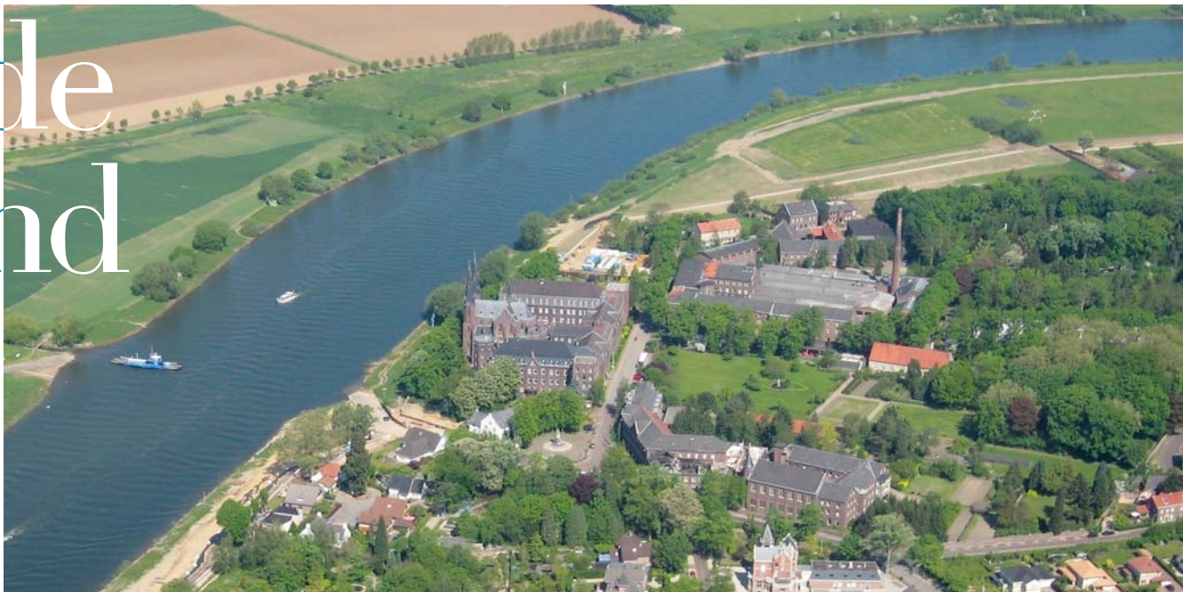
1 – DEEL VAN HET KLOOSTERDORP STEYL MET MIDDENONDER HET DOOR BRAND GETROFFEN ST. GREGOR-KLOOSTER. TE ZIEN IS HOE EEN GEDEELTE VAN DE KAP DOOR DE BRAND IS INGESTORT (FOTO PETER TIMMER)
