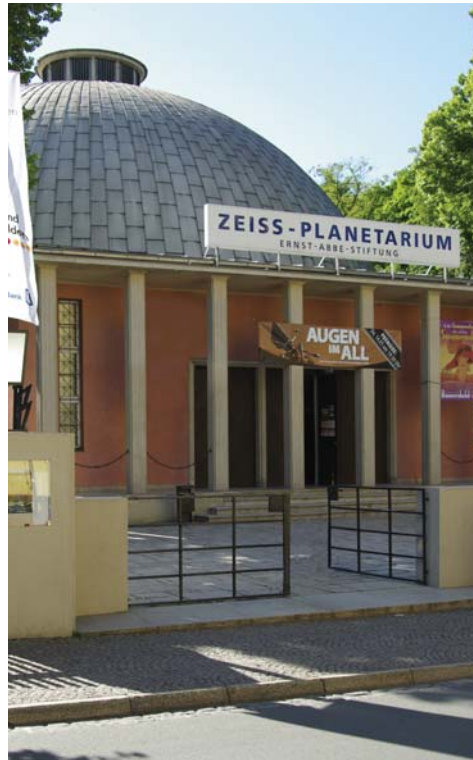
2 - JENA, PLANETARIUM GEBOUWD VOLGENS HET ZEISS-DYWIDAG-SYSTEEM, 1926.
