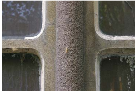
10 ▼ - ROTTERDAM, DETAIL VAN DE RIVIÉRAHAL IN DE DIERGAARDE BLIIDORP MET SCHOKBETON VENSTERS EN LICHT PAARS GEKLEURD SCHOKCRETE SIERBETON.
