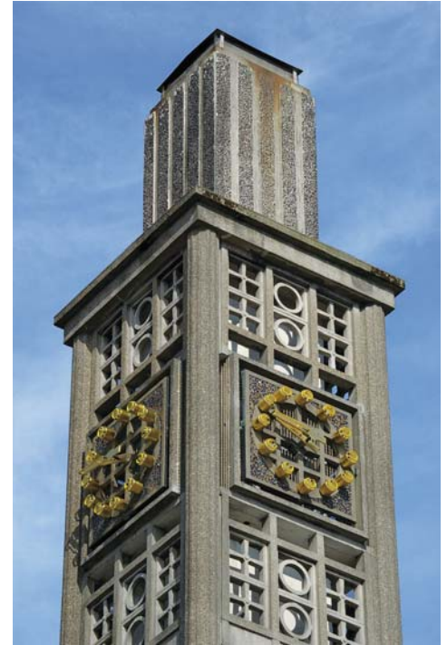
10 ▼ - ROTTERDAM, DETAIL VAN DE RIVIÉRAHAL IN DE DIERGAARDE BLIIDORP MET SCHOKBETON VENSTERS EN LICHT PAARS GEKLEURD SCHOKCRETE SIERBETON.
