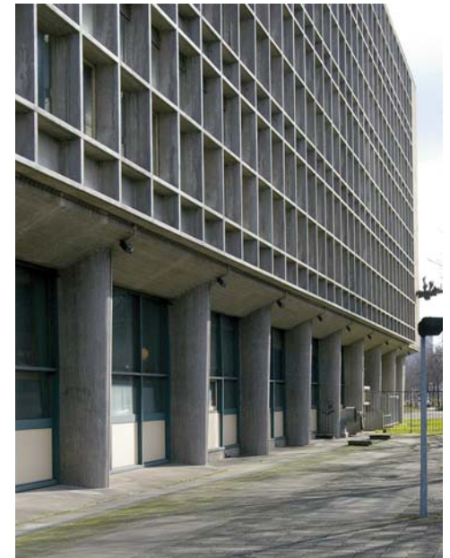
14 - AMSTERDAM, CHR. LAGERE EN MIDDELBARE TECHNISCHE SCHOOL PATRIMONIUM AAN DE VROLIKSTRAAT MET EEN BETONSKELET EN BEKLEDING MET SCHOKBETONELEMENTEN, 1956-1957. FOTO 2009
