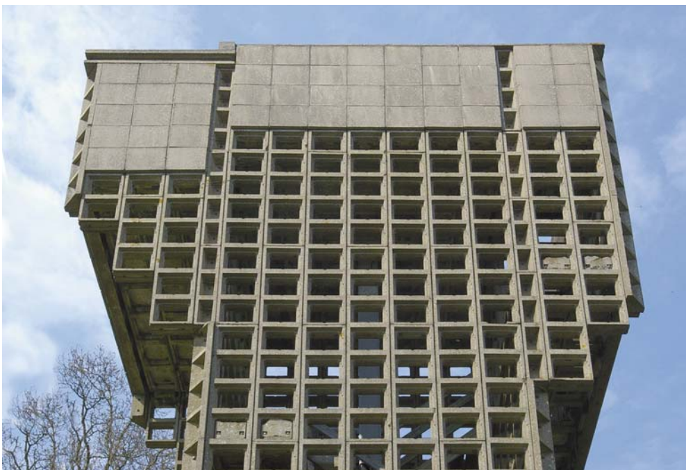
12 - OUDEMIRDUM, LUCHTWACHTTOREN VOLGENS HET RAAT-SYSTEEM, 1953. FOTO 2009
