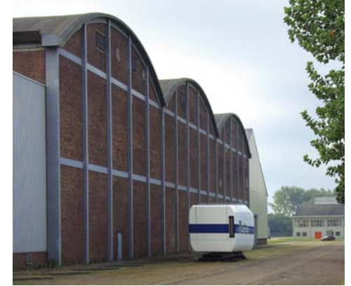
3 - ARNHEM, TONSCHALEN VAN DE DRIEBEUKIGE STROLOODS VOOR DE ALGEMENE KUNSTZIJDE INDUSTRIE IN DE KLEEFSE WAARD, 1942.
