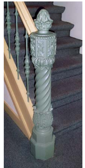
Trappaal van de monumentale trappartij met bovenlicht.
