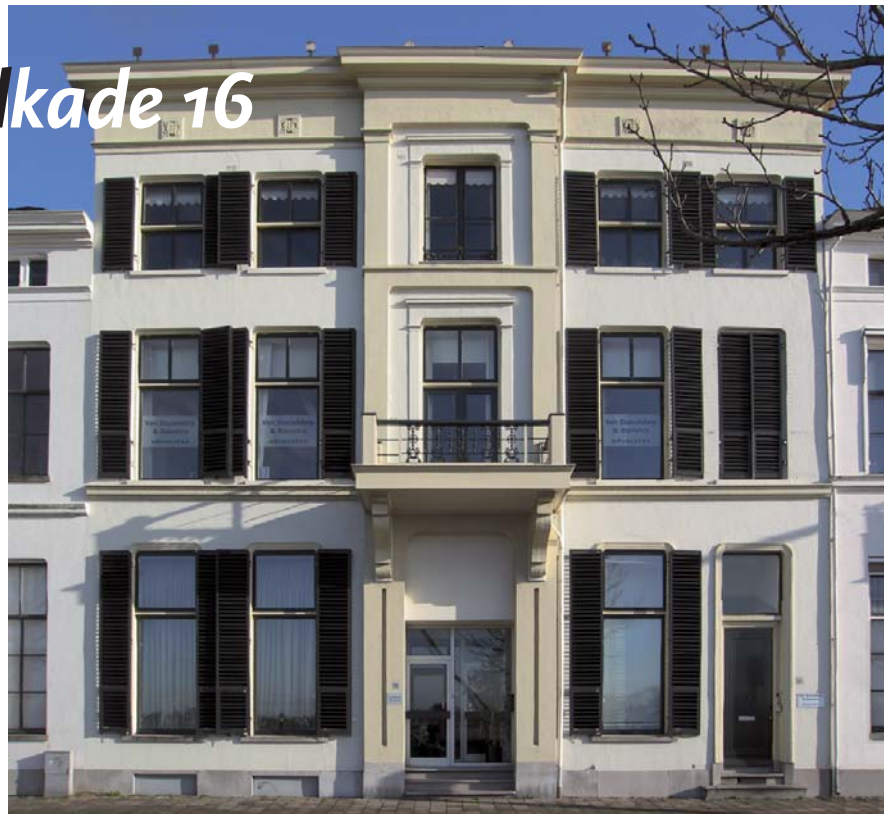
Statige voorgevel van IJsselkade 16 te Zutphen
