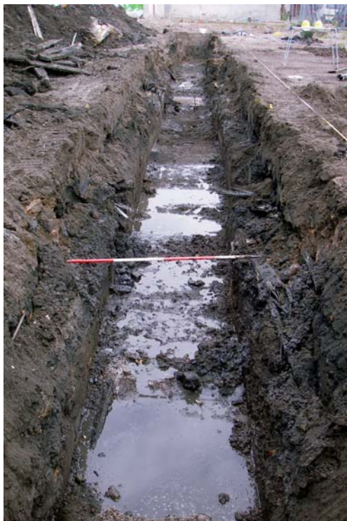
3 – Voorbeeld van archeologievriendelijk bouwen: het oude riool is verwijderd, het nieuwe kan straks in dezelfde sleuf worden teruggeplaatst.
