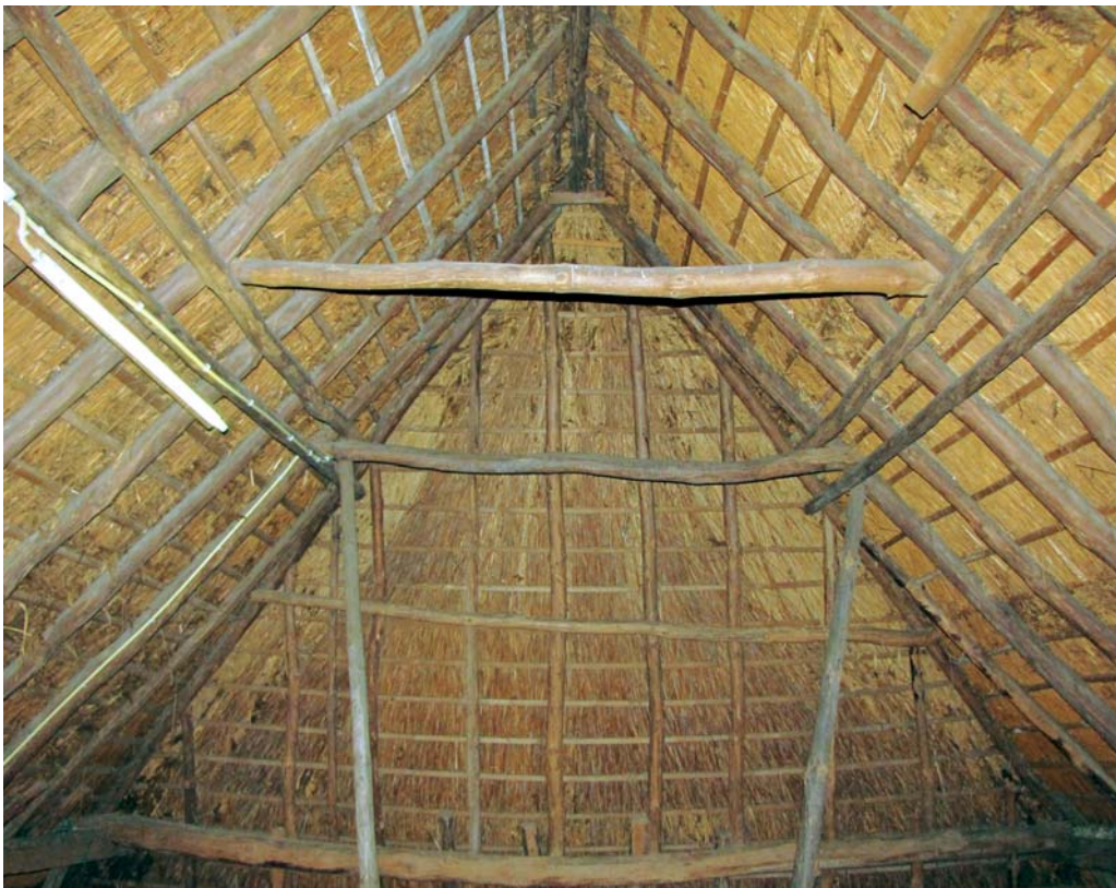
De rondhouten kapconstructie.
