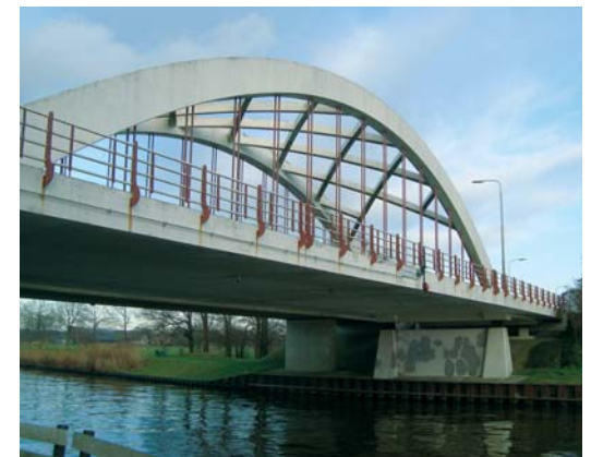
9 - DE COTTWICHERBRUG. NA HET GRAVEN VAN DE TWENTEKANALEN ZIJN TUSSEN 1930-1937 VIJFENTWINTIG VERKEERSBRUGGEN AANGELEGD. KENMERKEND VOOR DE COTTWICHERBRUG IS HET RUITVORMIGE BOVENWINDVERBAND.
