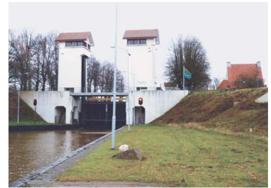
8 - SLUISCOMPLEX DELDEN. EEN VAN DE OBJECTEN AAN HET TWENTEKANAAL IS HET SLUISCOMPLEX DELDEN. HET COMPLEX BEVAT NAAST DE SLUIS EEN GEMAAL EN EEN BRUG. DE DIENSTWONINGEN DIE OOK BIJ HET COMPLEX HOREN, ZIJN NIET MEER IN BEHEER BIJ RWS. VOOR EEN SLUIS MET HEFDEUREN IS HET BIJZONDER DAT DE BEIDE HEFTORENS NIET MET ELKAAR VERBONDEN ZIJN.
