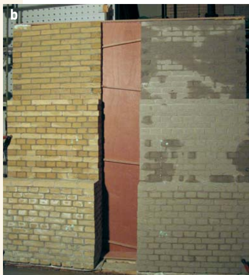
6B NA 2 UUR BEREGENING (MET 50 PA OVERDRUK) IN HET 1/2-STEENS GRIJZE (MATIG ZUIGENDE) METSELWERK IS DUIDELIJK TE ZIEN DAT DE VOEG (OF LIEVER HET HECHTVLAK STEENVOEG) DE ZWAKKE STEEN IS. DE TEKENING VAN DE GRIJZE STENEN VINDT PLAATS VANUIT LEKKAGE DOOR HECHTVLAKKEN.
